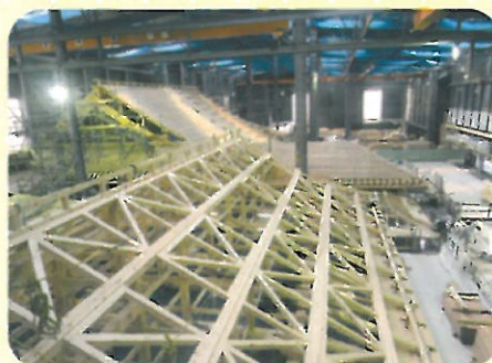
〈本丸御殿 復元工事〉
