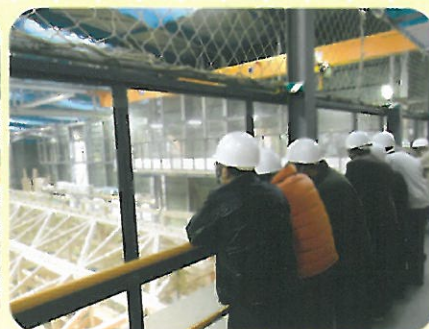
〈復元工事見学〉
